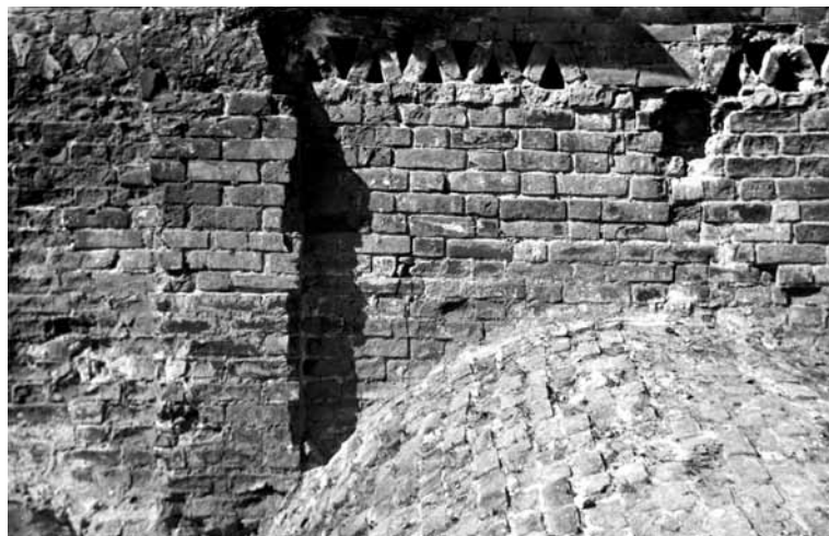
Ил. 22. Северная сторона стены алтарной части.
