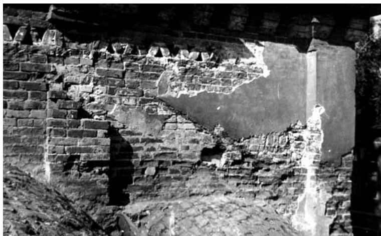
Ил. 23. Следы нескольких кровель.
